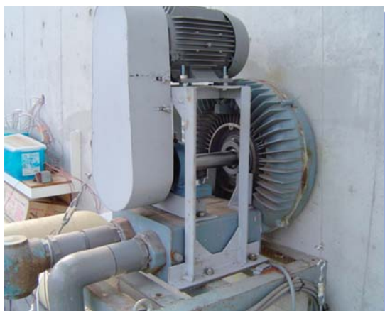
▼吸引通気用に改良した渦流送風機
