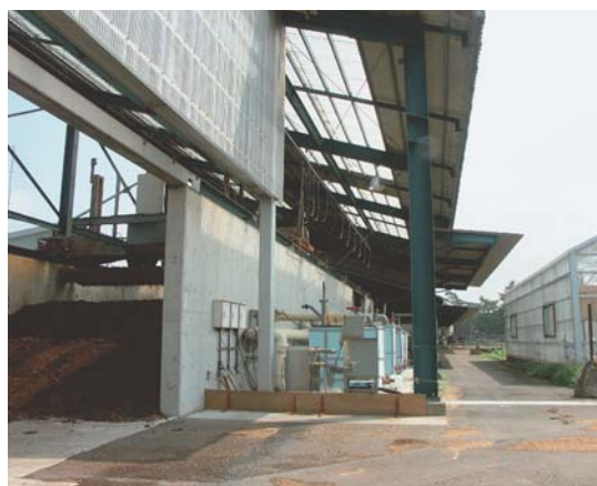
▼堆肥発酵槽（左）、簡易スクラバ（中央）および 廃熱利用ハウス（右）
