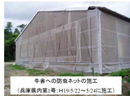
写真4 牛舎への防虫ネット施工 (県内第1号: H19/5/22～24に施工)
