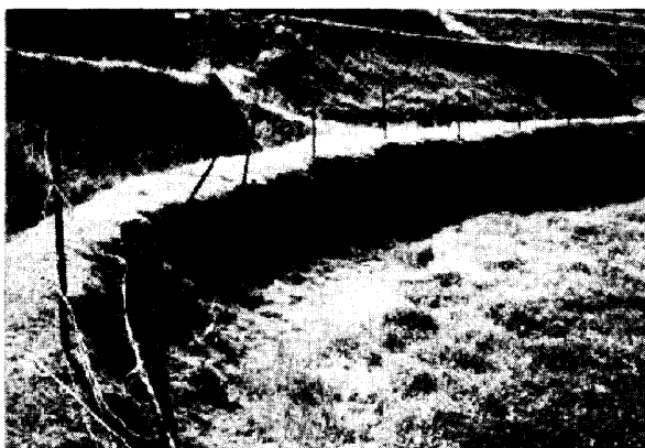
図6 牧柵を法面の上縁に設置したために牛によって崩され裸地化した。
